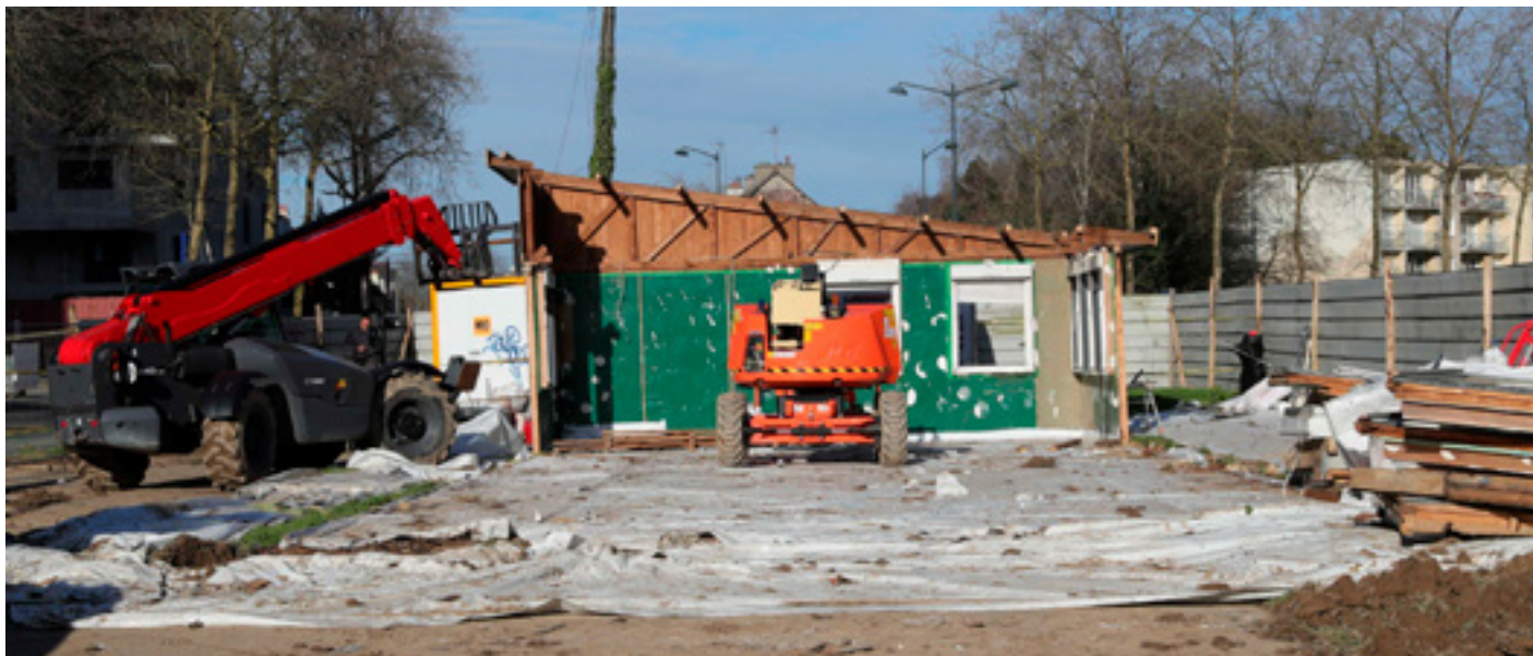
✓ Chantier démolition de la Baraque Ar Maure
